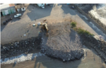
Boingoma · remblai du terre-plein
