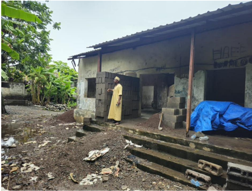
Photo 1 : Préfabrication de briques dans le bâtiment de l'ancien quai de débarquement
