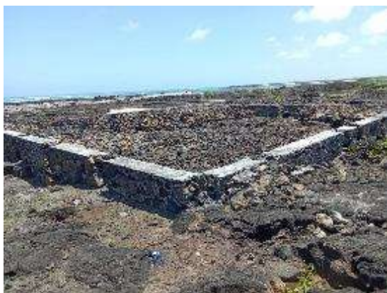
Photo 8 : Vue du bâtiment impacté dans l'emprise de la route d'accès au site portuaire
