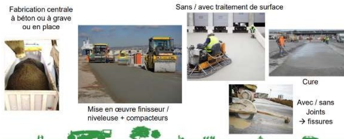
Figure 15 : Principales étapes de réalisation d'une chaussée en dalle courte. Source : CIMBéton
