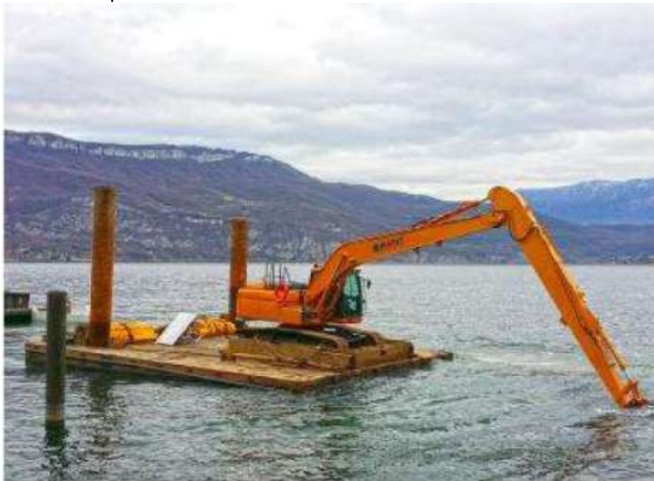
Figure 13 : Exemple pelle grande géométrie sur ponton motorisé (source : Bibaut environnement)
