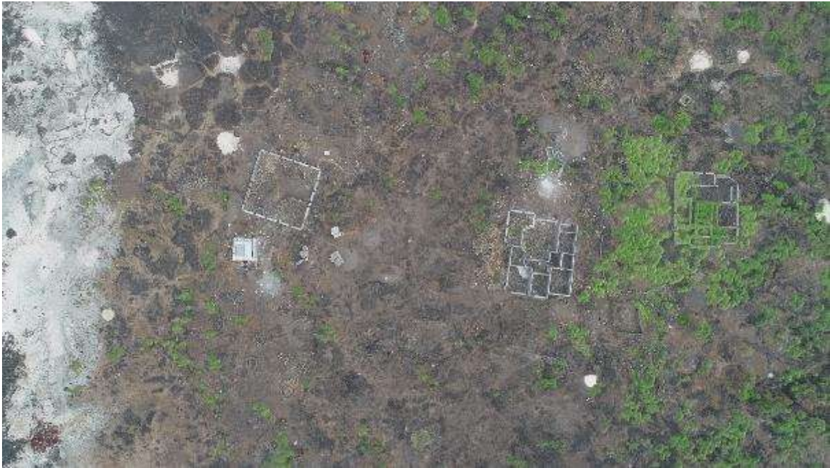
Photo 6 : Occupation autour du site du projet, maisons en construction
