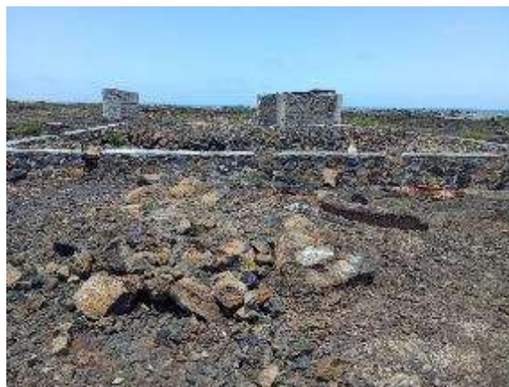
Photo 9 : Vue du bâtiment comprenant le réservoir à eau impacté dans l'emprise de la route d'accès au site portuaire
