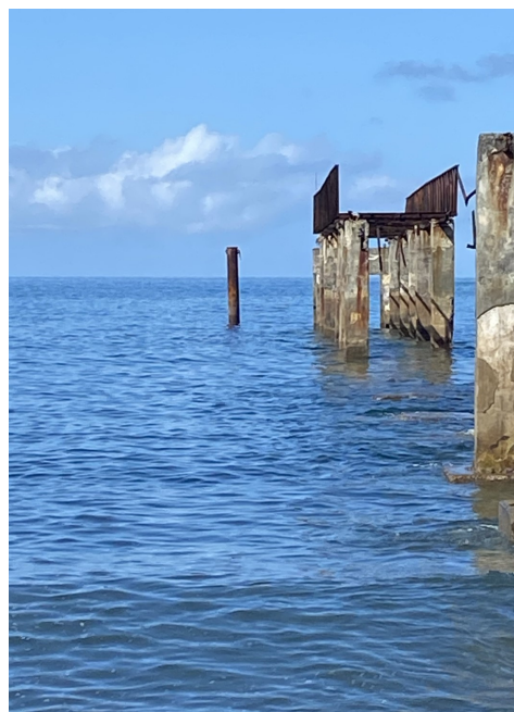
Figure 23 - Jetée sur pieux béton à Vassy (source: Egis, 2021)
