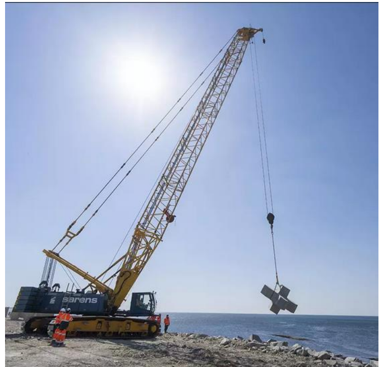
Figure 686 : Pose de blocs artificiels par une grue (photo Charrier)
