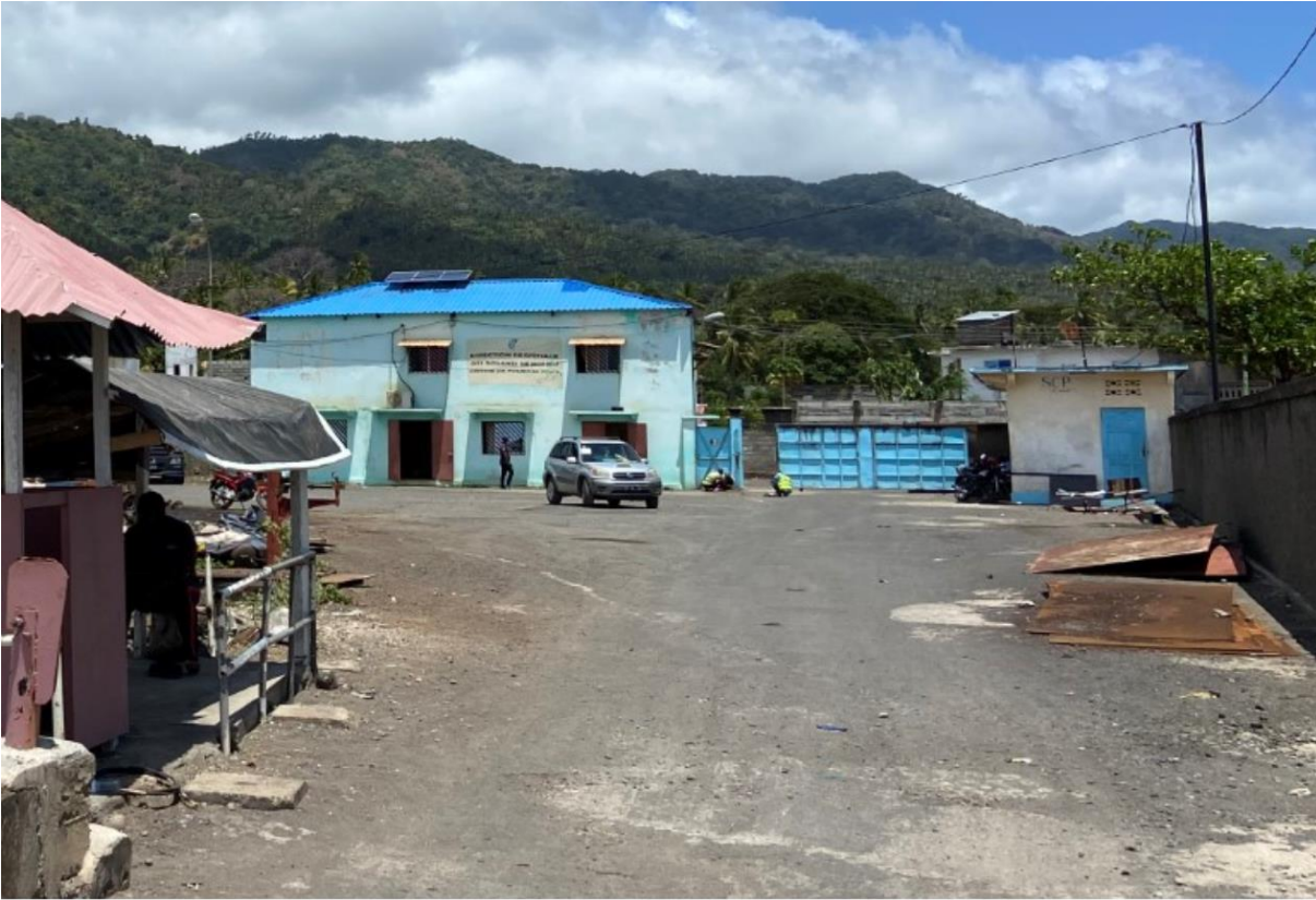
Figure 28 - Portail et accès actuels (source : EGIS, 09/2021)
