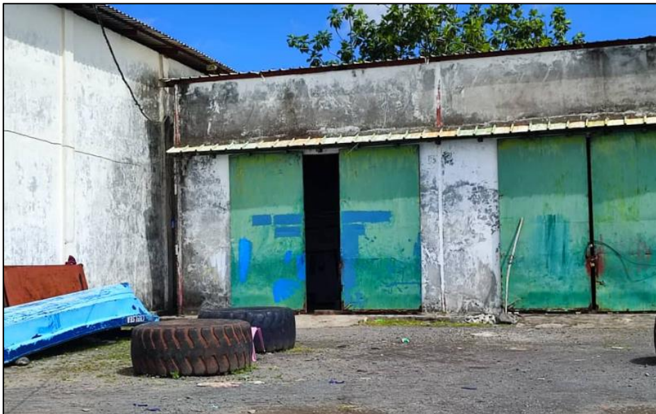
Figure 44: Ancien magasin portuaire abritant désormais le matériel des gardes côtes
