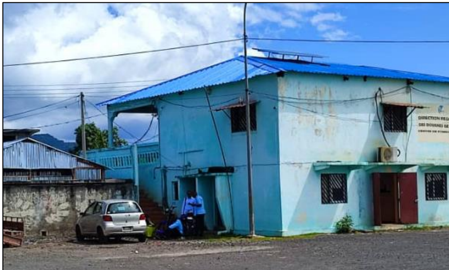
Figure 46: Service des douanes actuel
