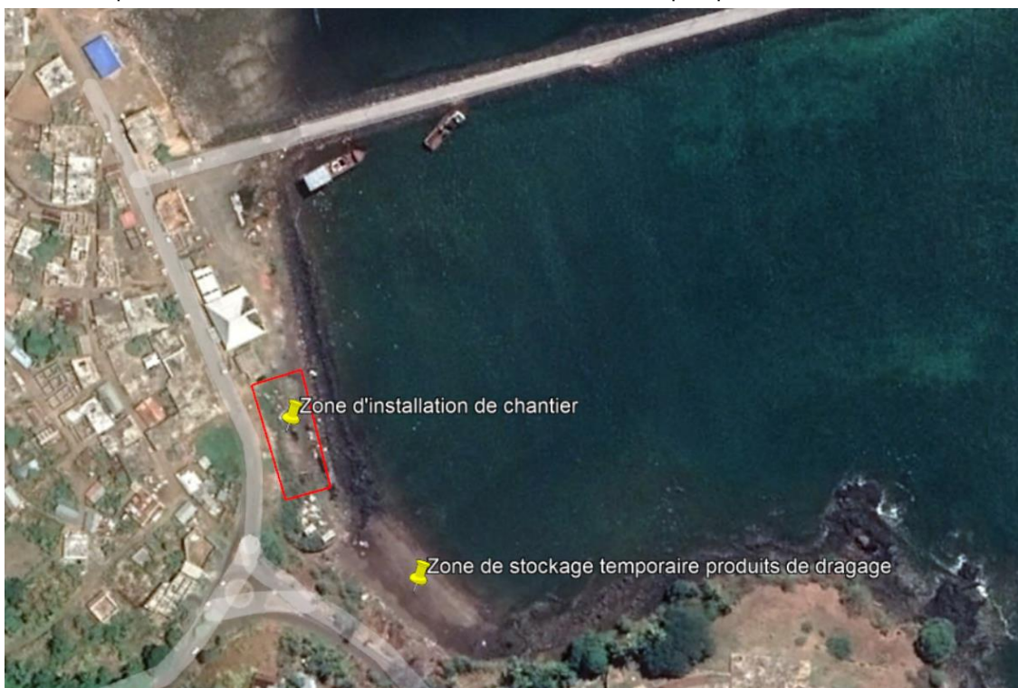
Figure 20 - Zone de stockage produits de dragage
