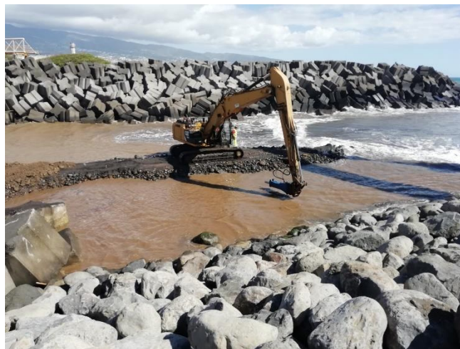
Figure 21 – Pelle sur ponton, pelle amphibie, pelle terrestre à bras long
